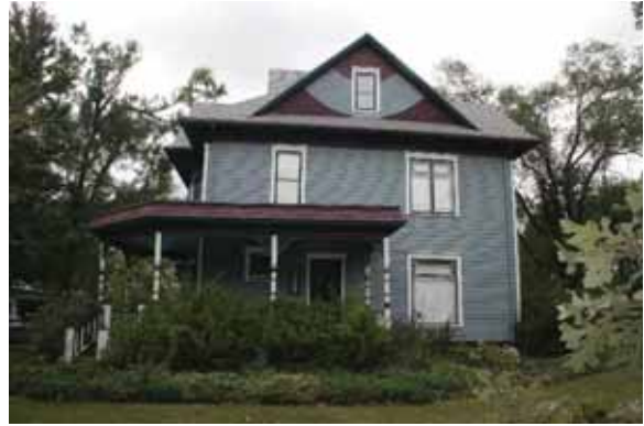
Brecheisen, John H., House
